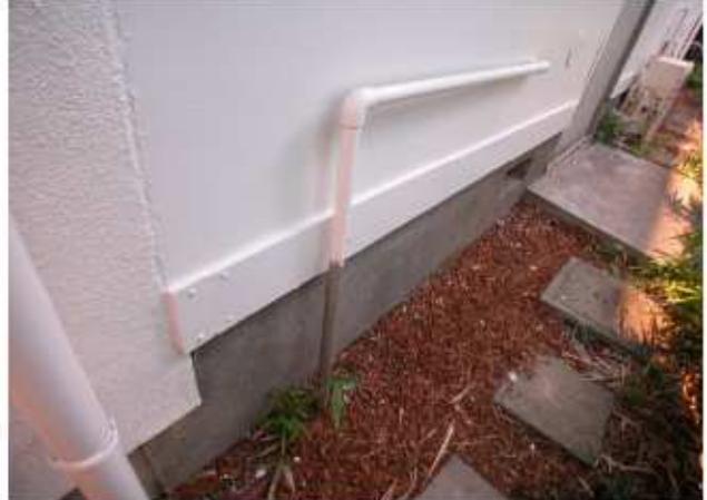
まず、外壁パネルの酷く剥がれた箇所は雨漏りしないようにケイカル板を張り、これ以上剥がれないように処置をしました。
