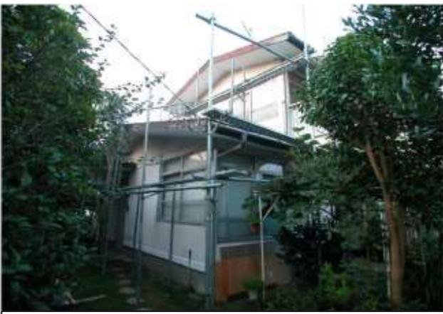
足場を組み、屋根の重ね葺きを行いました。築 40 年のコロニアルの屋根でしたから、表面が剥げてだいぶ痛んでいた様子でした。幸い屋根下地がしっかりしていましたので、アメリカ製の軽い屋根材「ファイバーグラスシングル」を重ね葺きすることにしました。この工法ですと、解体時のアスベスト飛散もなく安全で、屋根が2重構造になることから、室内の断熱性能が向上して、冬暖かく、夏涼しい家に生まれ変わります。
