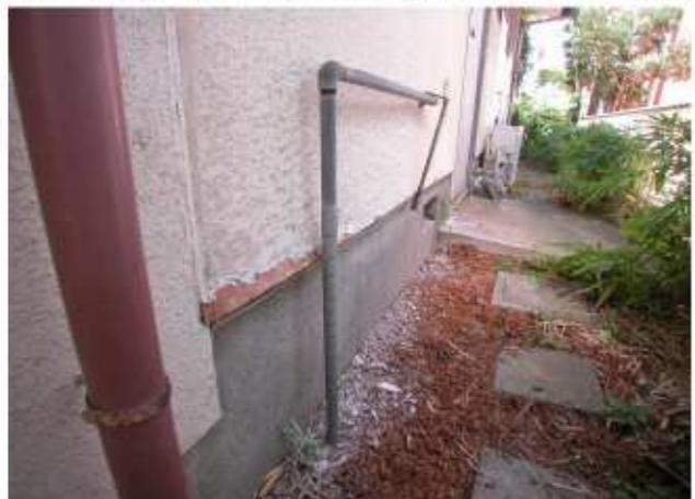
まずは現場調査をしました。外壁・屋根は塗装がひどく剥がれている状態で、外壁パネルの下端部分が腐食してめくれ上がってきました。このまま放っておくと雨漏りの原因にもなります。濡れ縁はシロアリに食われてボロボロのため撤去し、新しいものを設置することになりました。打ち合わせは北海道の息子さんとはメールで、お母さんは直接お会いして打ち合わせをしていきました。
