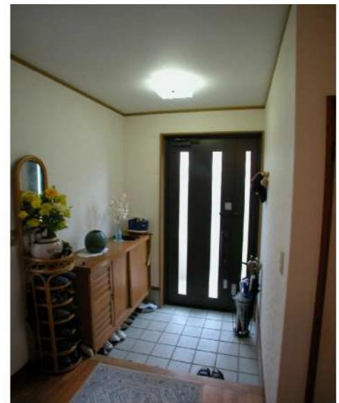
玄関ドアはアルミ製のシックなフロント色の扉に交換。今までドアの上にガラスの欄間が付いていましたが、今度は大きな一枚の扉で立派です。大きな荷物の出し入れに備えて、親子ドアに変えました。テリー君があけた壁の穴を大工の村上が丁寧にふさいで、パテを打って、上からクロスを貼りました。クロスを貼り替えるだけで、部屋の明るさが違います。
