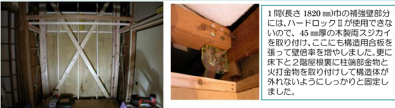
1間(長さ 1820 mm)巾の補強壁部分には、ハードロックIIが使用できないので、45 mm厚の木製両スジカイを取り付け、ここにも構造用合板を張って壁倍率を増やしました。更に床下と2階屋根裏に柱端部金物と火打金物を取り付けして構造体が外れないようにしっかりと固定しました。
