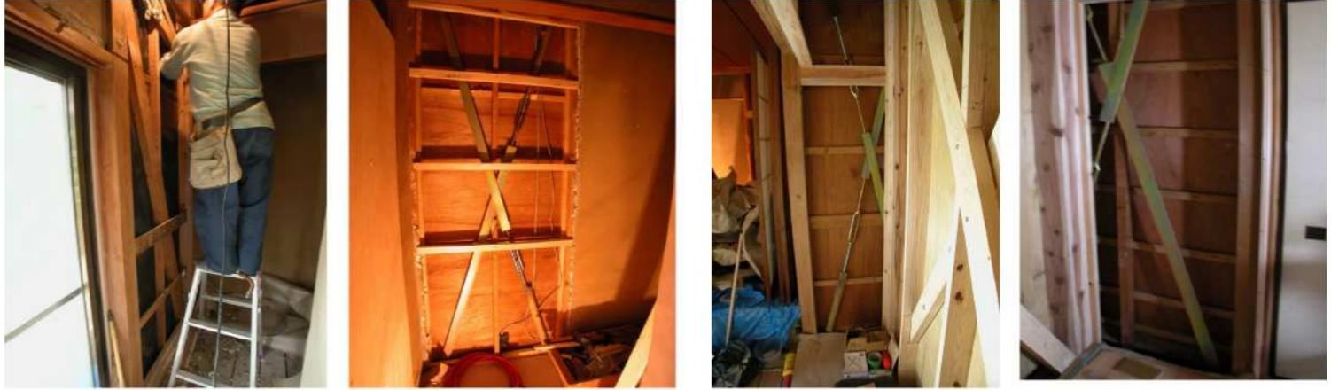
まず1階中央部分の和室(主寝室)を中心に国土交通省認定の耐震補強金物ハードロックIIを5ヶ所取り付け、その上に構造用合板を張り、壁倍率を増やしました。
