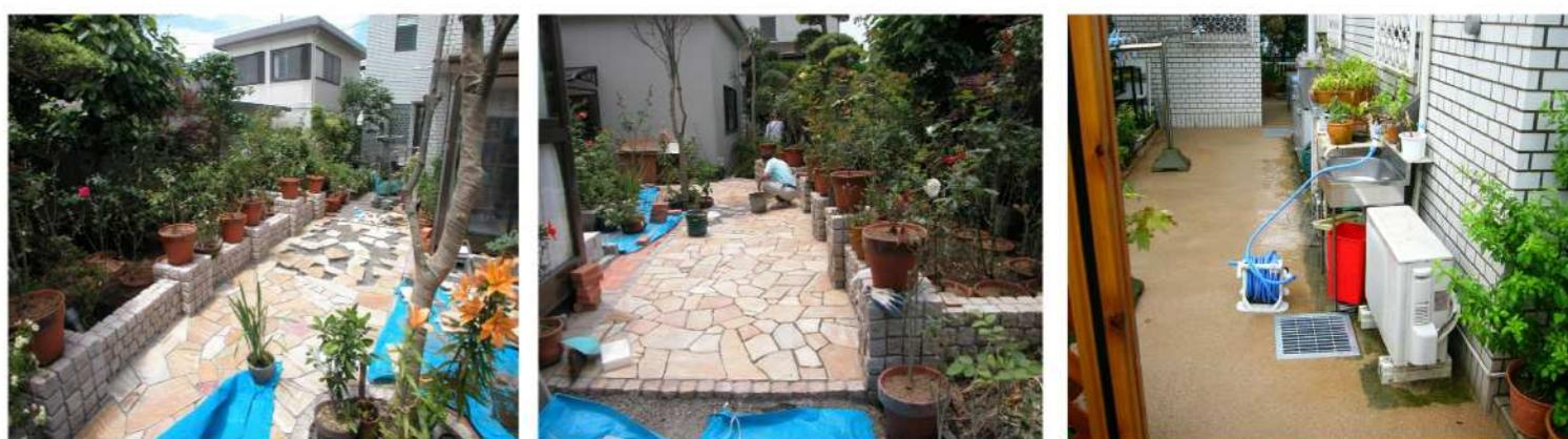
ジェラストーンの乱貼りとレンガ貼りの作業です。一枚一枚の手作業です。裏の通路は防草舗装を施工。明るい感じになりました。草も生えず、水も浸透していきます。
