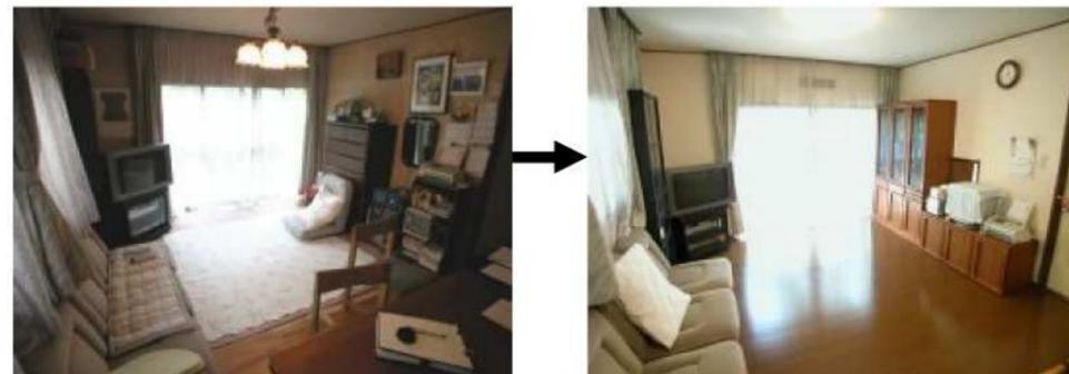
床の状態が一番酷かったリビング。床下地から全て交換して、綺麗なフローリング貼りになりました。壁と天井のクロスも貼り替え新築同様。おまけに2重サッシのインプラスで防音対策もバッチリです。
