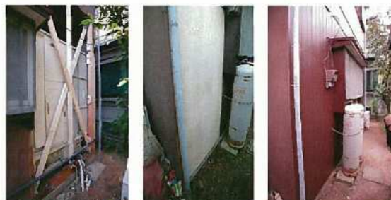
土台と新しい通し柱をしっかり固定して、外壁材を貼りきれいに塗装すると、まるで何もなかったかのようです！
