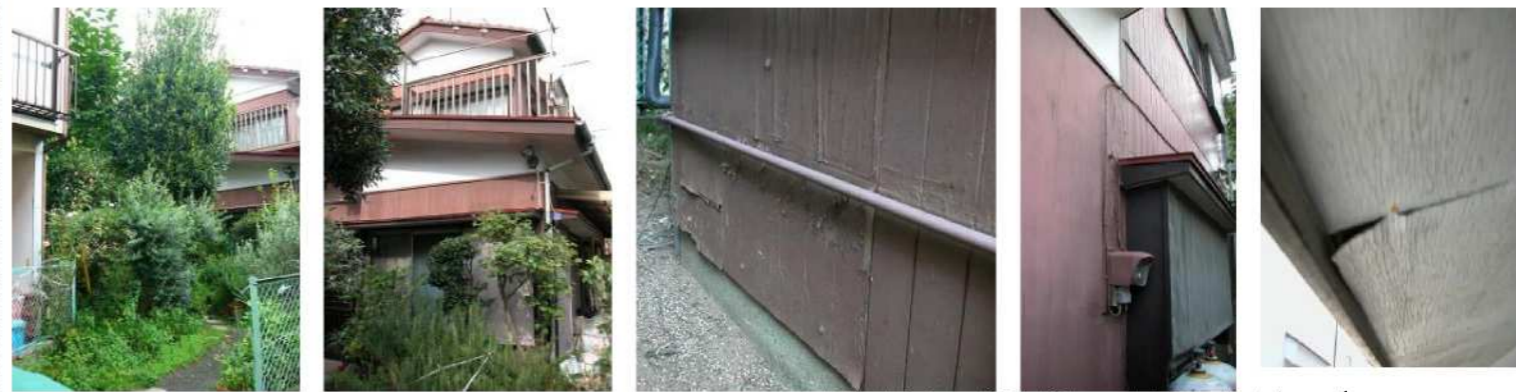
外壁や軒天が剥がれ、外壁に大きなヒビ割れがあるのがわかります。
